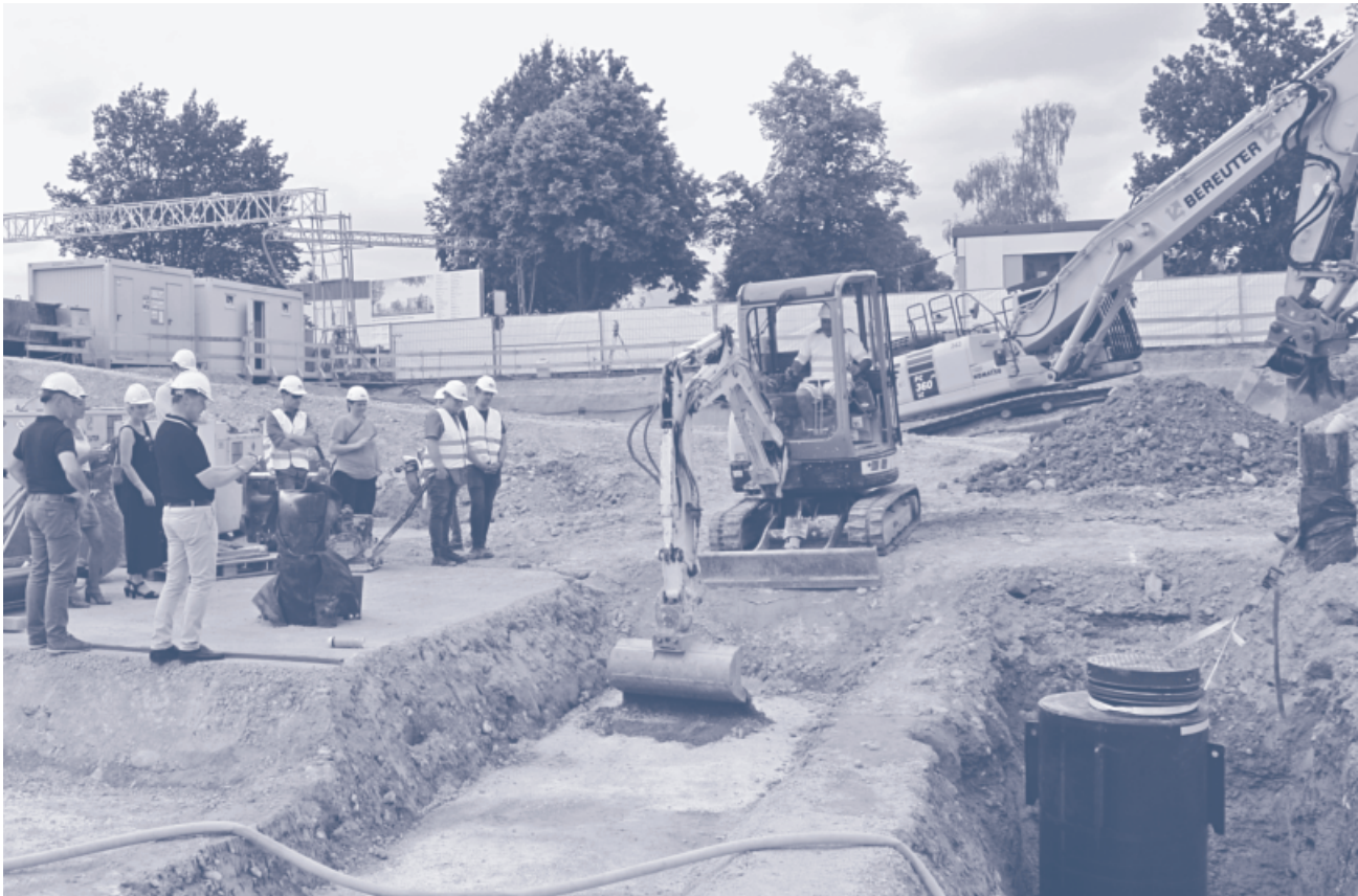
Die kleine Grube für die Grundsteinlegung wird ausgehoben.
